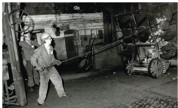
Opróżnianie retorty ze zgazowanego węgla w gazowni w wielkopolskim Śmigłowie ok. 1980 r., foto Archiwum FOMT
