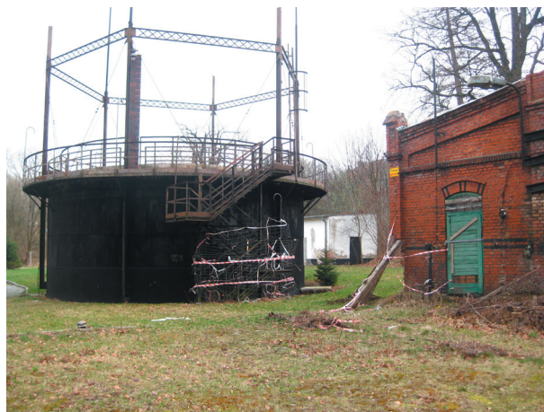
Międzyzlesie, Teleskopowy zbiornik gazu typu mokrego, foto S. Januszewski, 2013
