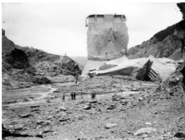
Fragment zapory St. Francis po katastrofie
