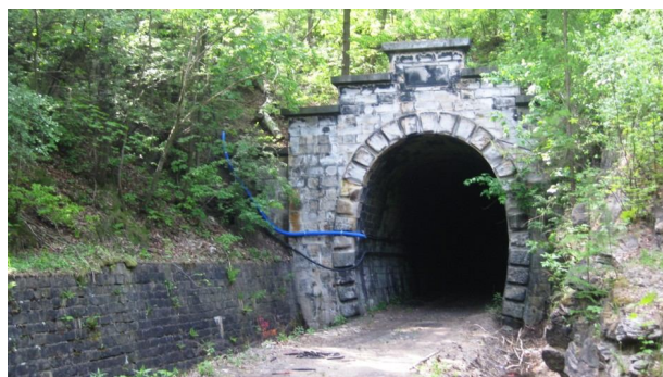
Najdłuższy tunel kolejowy w Polsce
