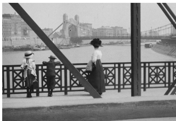
Fragment żeliwnej balustrady z mostu Lessinga wydobyty z dna rzeki; fragment fotografii z 1913 r. wykonanej z mostu, http://dolny-slask.org.pl/4304229,foto.html?idEntity=537939
