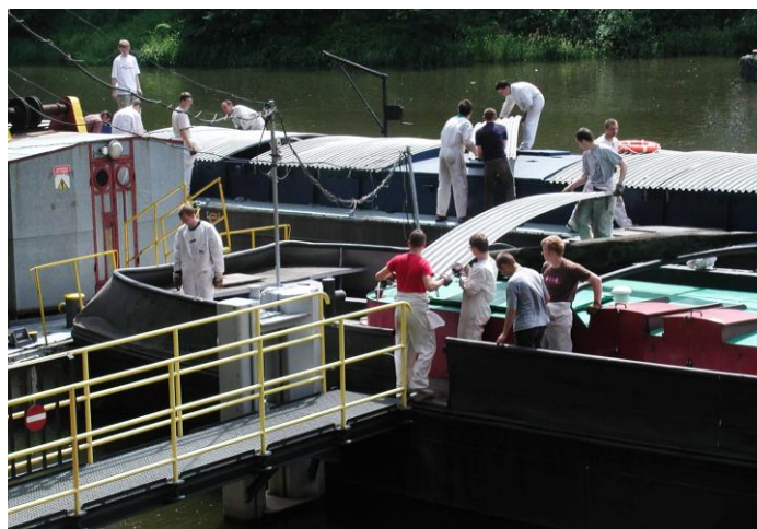
Rok 2007, montaż ferdeków po ich wyremontowaniu
