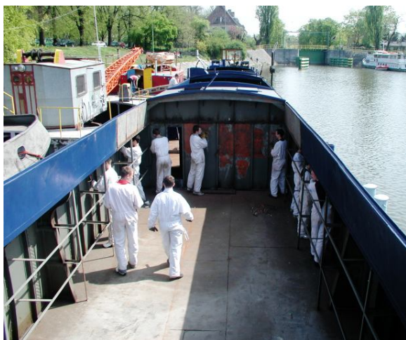
Rok 2007, prace antykorozyjne w ładowni dziobowej
