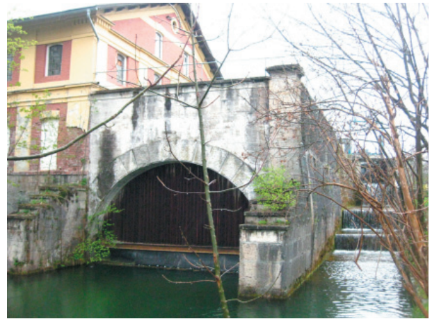
Most kanałowy elektrowni rzeki Schwarze Payerbach-Reichenau
