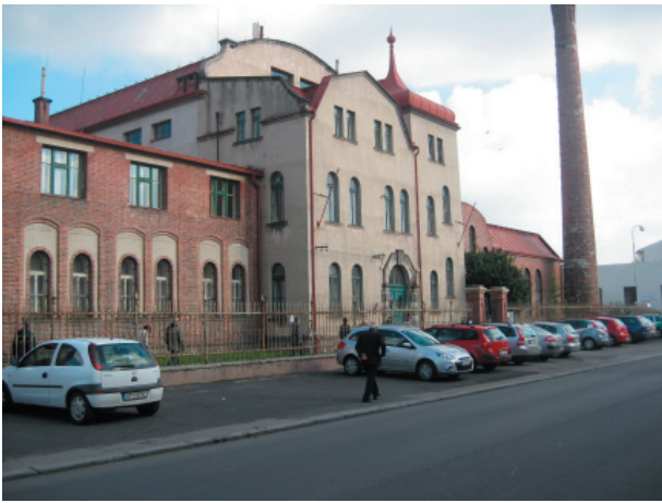
Oczyszczalnia ścieków czeskiej Pragi.
