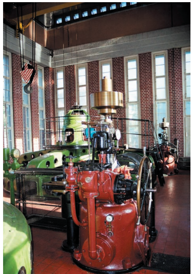
il. 10. Hydrozespoły elektrowni wodnej Północ
