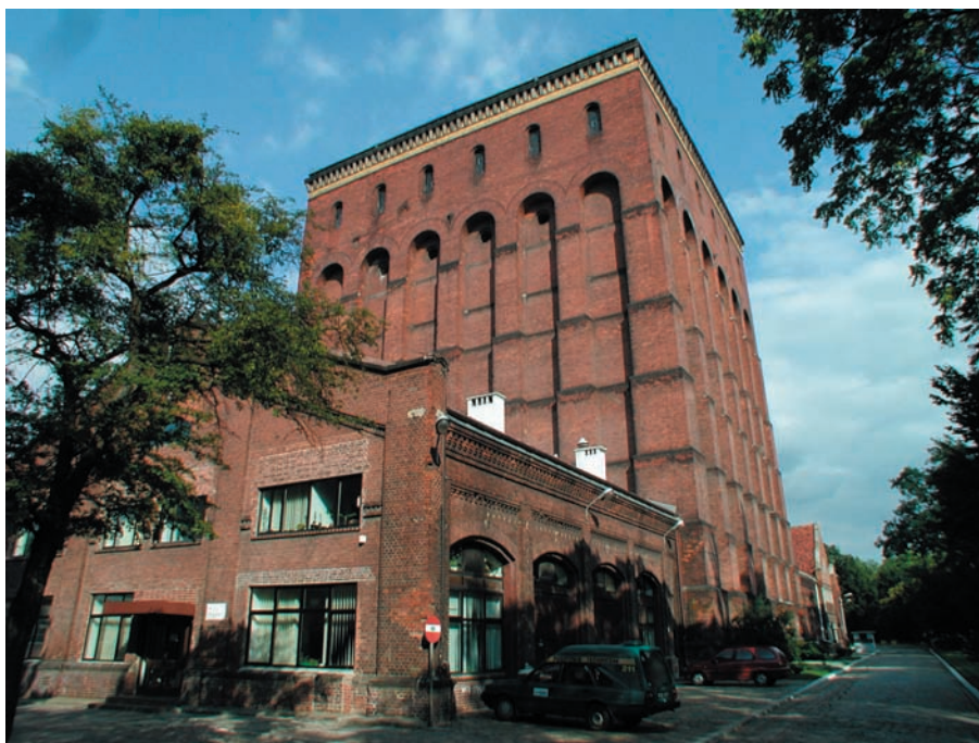
Il. 11. Zakład Wodociagowy „Na Grobli”
