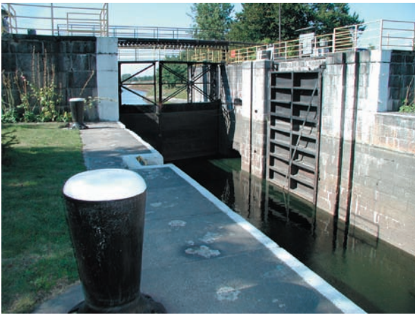
Il. 13. Śluza „Miejska” z wrotami dolnymi, podwójnymi, przeciwpowodziowymi
