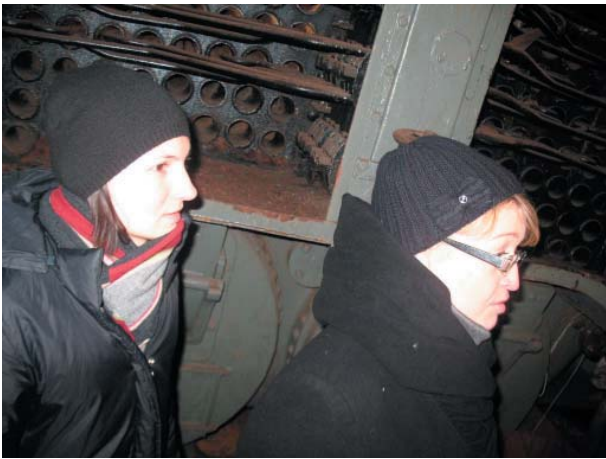
Panie w kotłowni NADBORA
