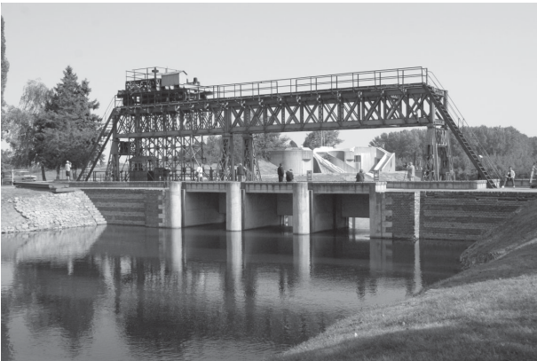
Głowa dolna śluzy – jaz piętrzący, w głębi trybuna przykrywająca dawną elektrownię wodną
