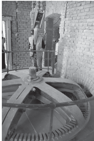
Przekładnia turbiny wodnej pracującej na wale pionowym
