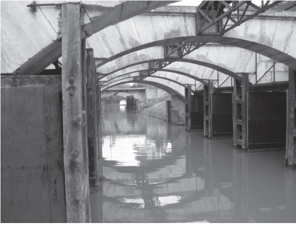
Szlak Kanału pod budowlą wrót powodziowych
