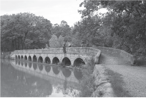
Upust wody z kanału do rzeki Argent Double
