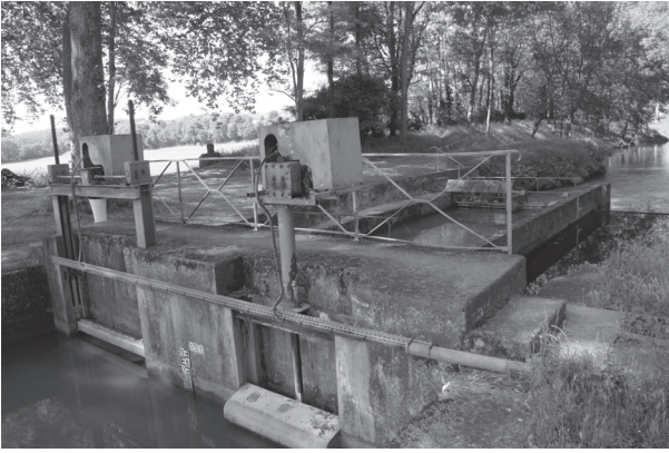
Upust zasilający Kanał w wodę na stanowisku szczytowym Nauroze
