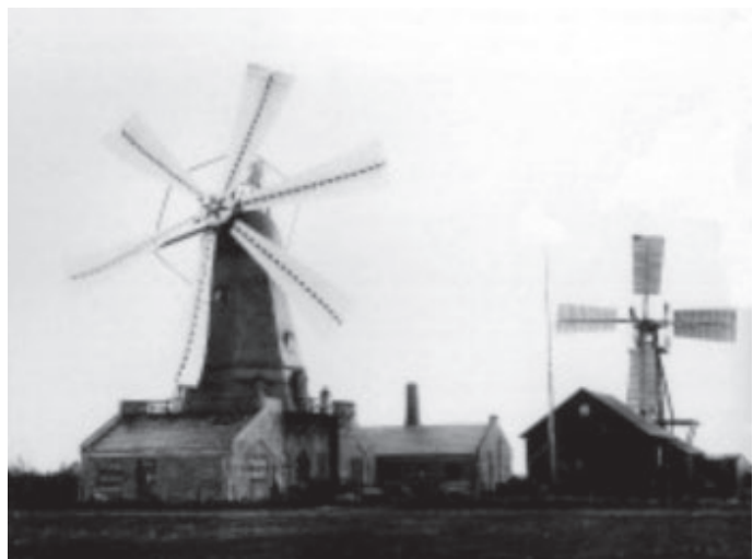
Pierwsza siłownia wiatrowa produkująca energię elektryczną, zbudowana przez Charlesa F. Brusha i elektrownie wiatrowe la Coura
