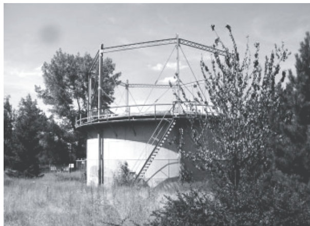
Gazownia w Sobótce – teleskopowy zbiornik gazu
