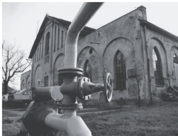
Gazownia w Piławie – dzisiaj rozdzielnia gazu ziemnego
