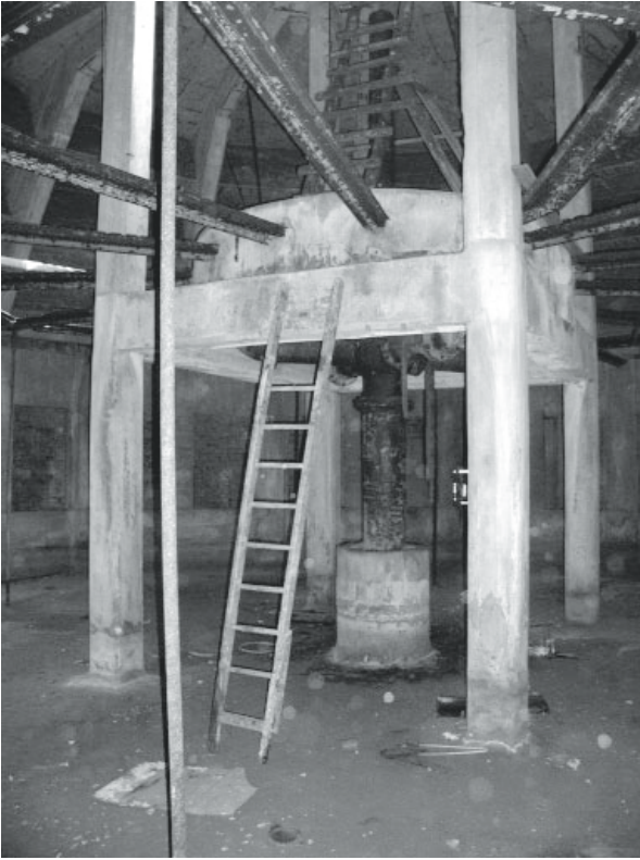
Zbiorniki w głowicy wieży
