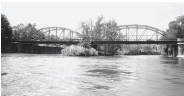
Fot. 1. Most Sikorskiego od strony mostu Pomorskiego Południowego
