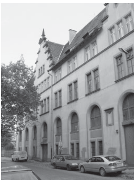
Budynek dawnego Urzędu Celnego przy porcie miejskim na Kępie Mieszczańskiej
