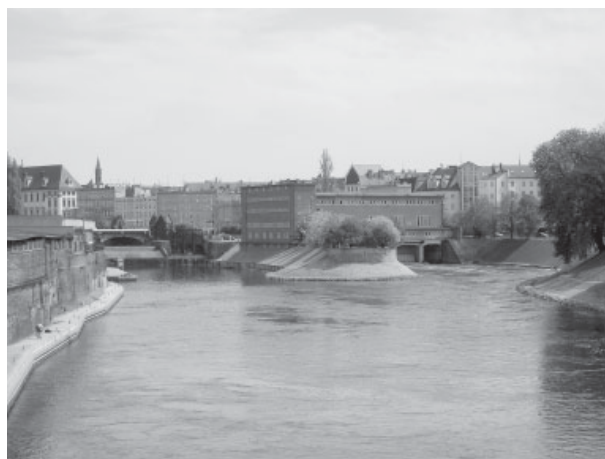
Elektrownia wodna Wrocław I Południowa – widok z mostu Sikorskiego
