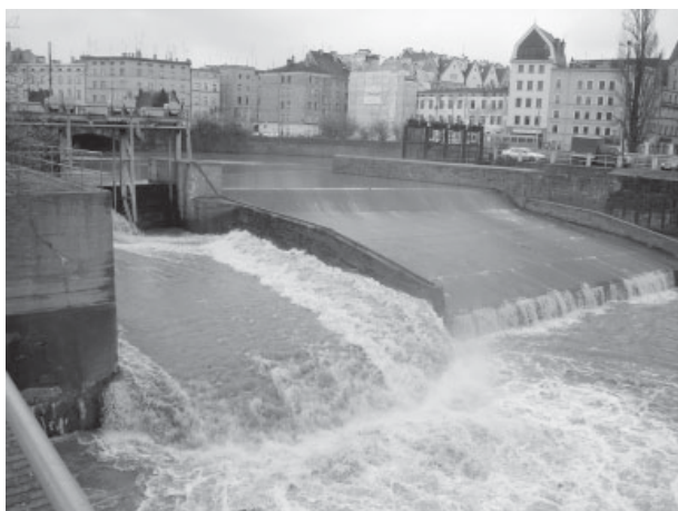
Jaz elektrowni wodnej Wrocław I w czasie pracy
