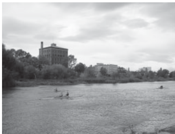
Widok na zakład wodociągowy Na Grobli z punktu widokowego na wschodnim cyplu wyspy
