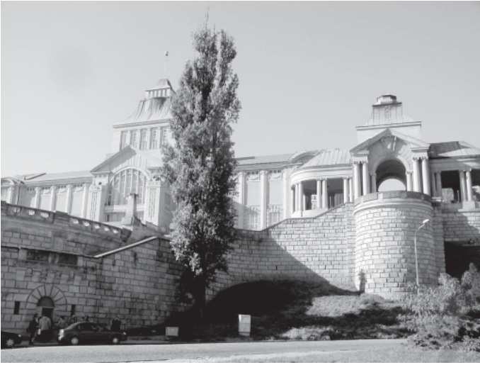
Żelbetowe budowle Muzeum Narodowego (1913) i tarasów 1902–1907
