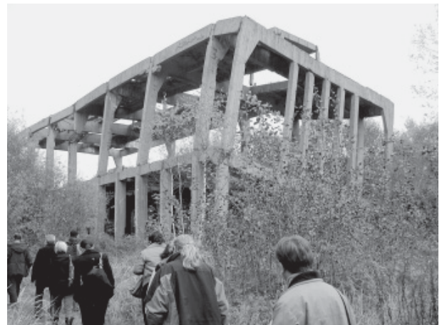
Ruina hali produkcyjnej Hydrierwerke
