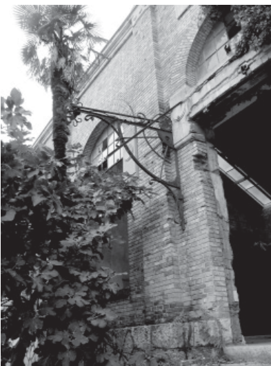
Siłownia elektrowni ciepłej 1907
