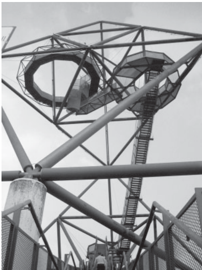
Bottrop. Teatralna konstrukcja przestrzenna na hałdzie kopalni
