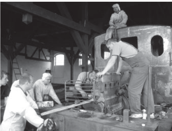
Montaż silnika po remoncie
