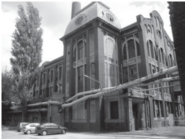
Elektrownia zakładu włókienniczego
