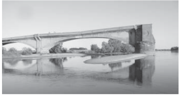
Most drogowy w Kłopotcie, zniszczony w 1945 r.
