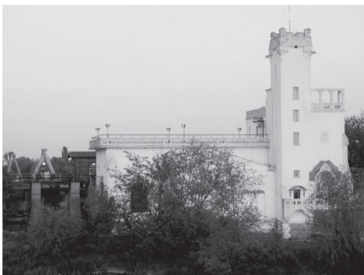
Powyżej: Elektrownia wodna Timisoara Obok: Huta Resita – wielki piec
