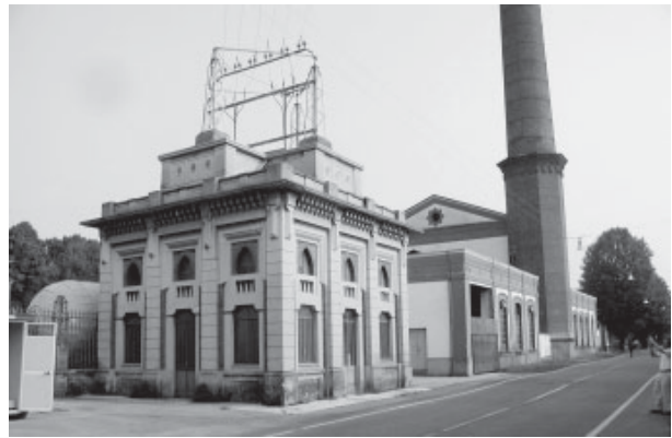
Crespi – kotłownia i siłownia
