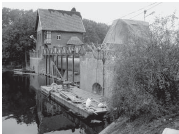
Jaz walcowy i elektrownia od południa
