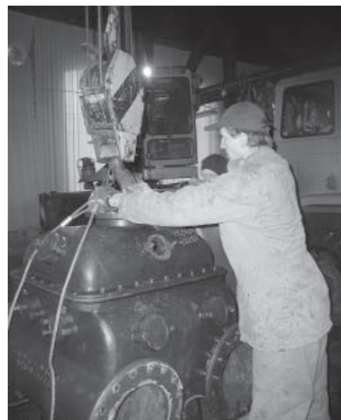
Wyładunek pompy w parowozowni
