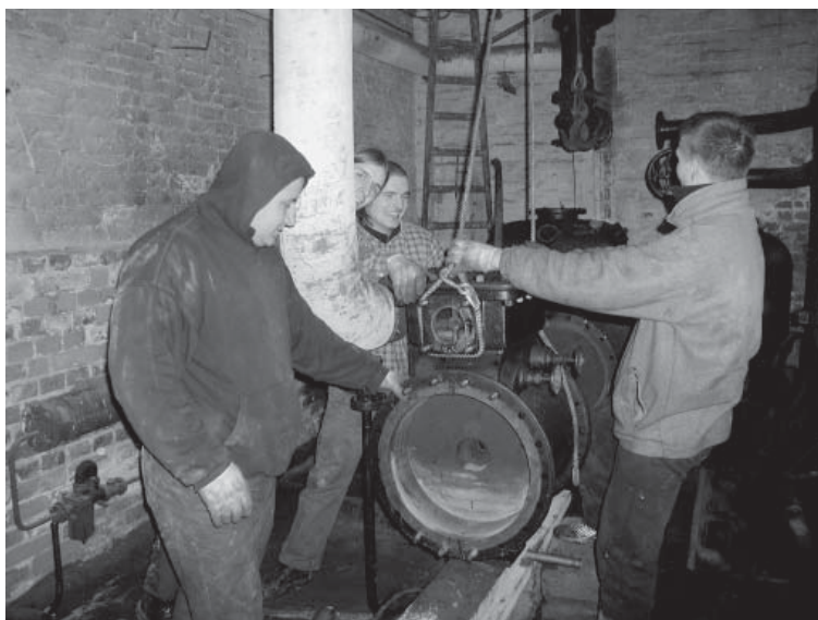
Studenci z MSKN „Ochrony zabytków techniki HP Nadbór” podczas demontażu i transportu agregatu
