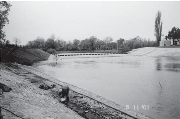
Widoczne od lewej: odbudowany wał przeciwpowodziowy, przepławka dla ryb, zmodernizowany jaz Szczytniki, sterownia jazu
