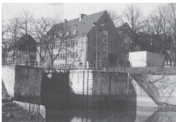
Widok na śluzę od dolnej wody
