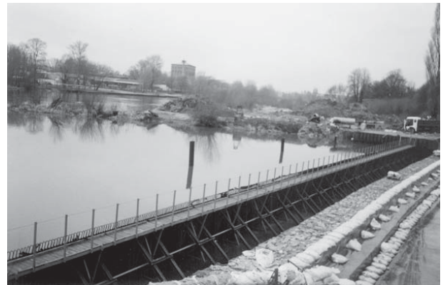
Zamknięcia remontowe jazu od górnej wody (konstrukcja kozłowo-iglicowa z kładką roboczą)
