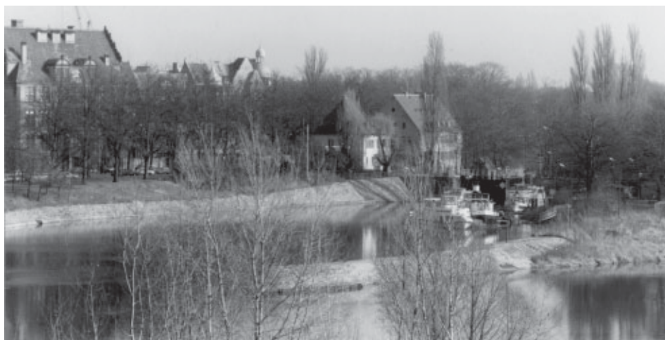
Budynki Szczytnickiego Węzła Wodnego od zachodu
