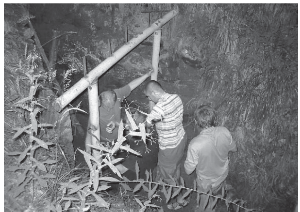
Roboty przy sztolni
