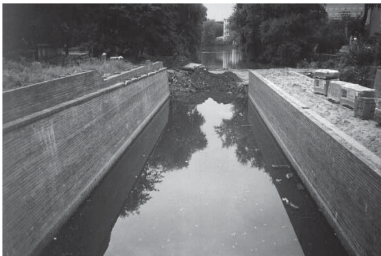
Śluza Mieszcząńska w trakcie odbudowy (fot. autor)
