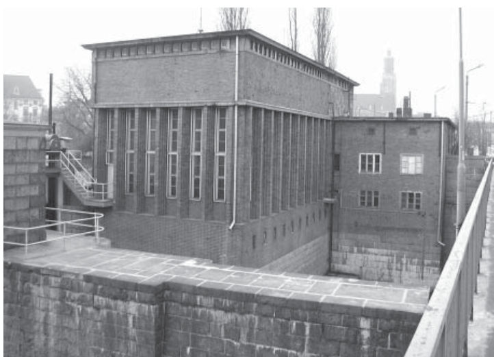
EW Wrocław II Północna – widok maszynowni z mostu Pomorskiego Północnego; fot. archiwum FOM
