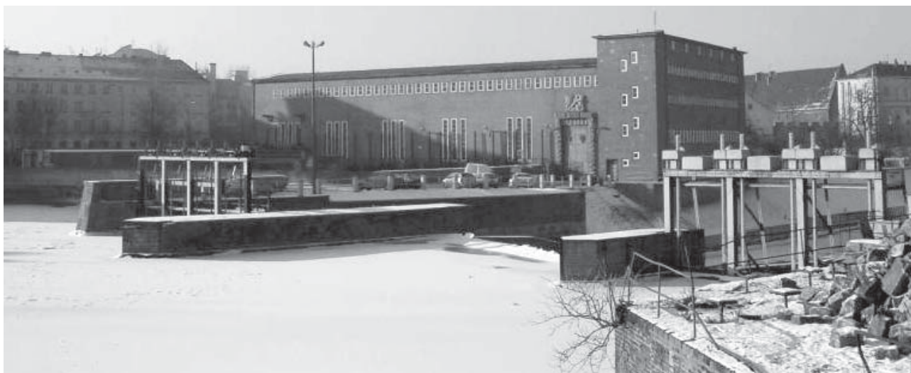
EW Wrocław I Południowa od wody górnej; fot. z Archiwum Zakładu Energetycznego SA
