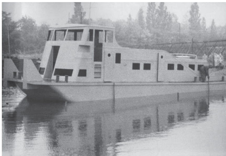
Pchacz MAZUR w trakcie budowy
