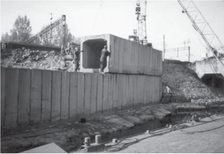
Montaż skrzyń nabrzeża
