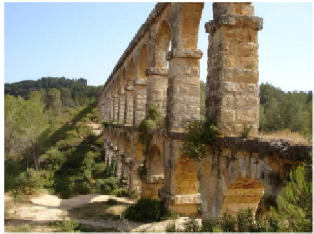
Akwedukt w Tarragonie, zwany mostem diabła (El Puente del Diable) z I w.n.e., długości 249 m i wysokości na 27 m, złożony z dwu pięter, dolnego liczącego 11 i górnego złożonego z 25 łuków
