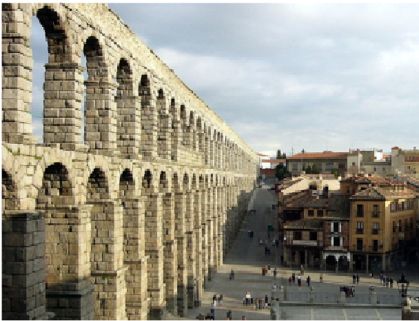
Akwedukt w Segovii z ok. 100 r. n.e., długości 15 km (pozostało ok. 800 m, 129 przęseł)
