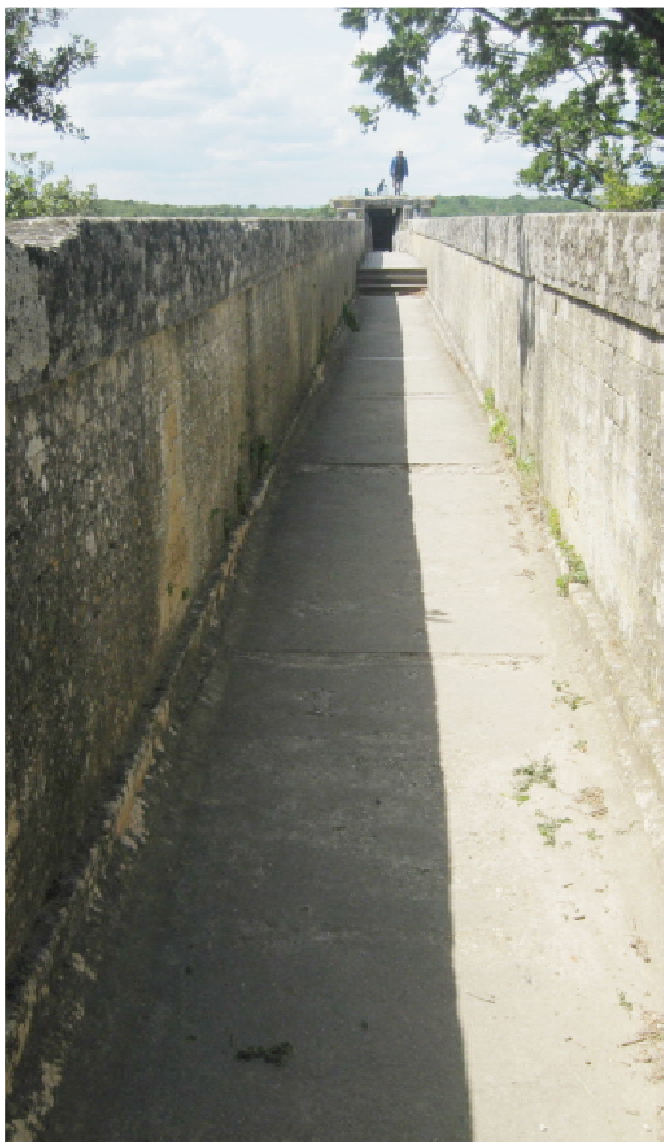
Kanał wodociągowy akweduktu Pont du Gard
